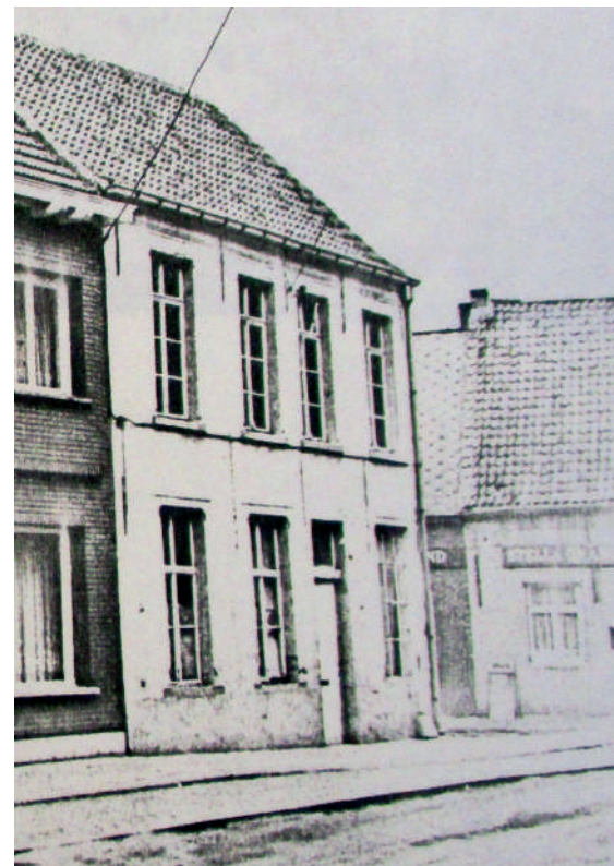
De woning A515 in de Dorpsstraat op het zuidelijke perceel van 'Landuytes' (fotoarchief J. Winckelmans)
